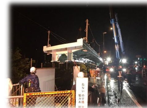
日立市245号側道橋
