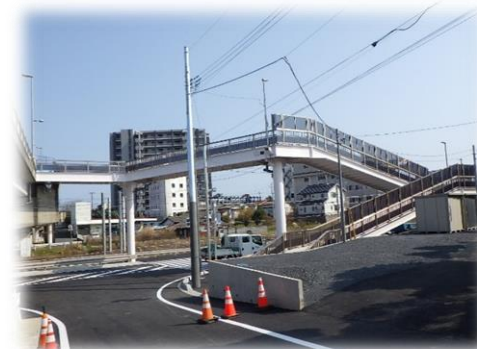
日立市大壺駅付近歩道橋
