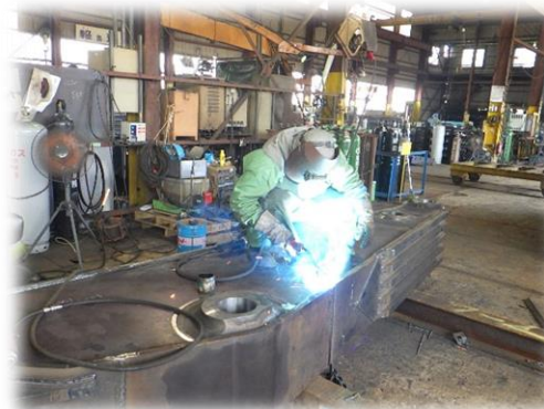
↑ 溶接(ようせつ)作業
